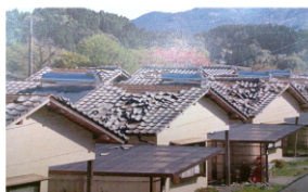
熊本地震による住宅破損 (図1:五ヶ瀬町)
